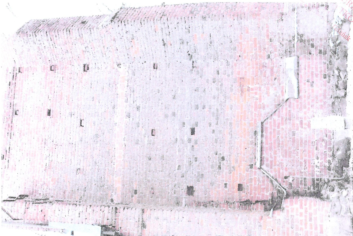
Fot.9 Północna elewacja wieży kościoła. Powierzchnia cegieł pokryta szarym nalotem porostów.
