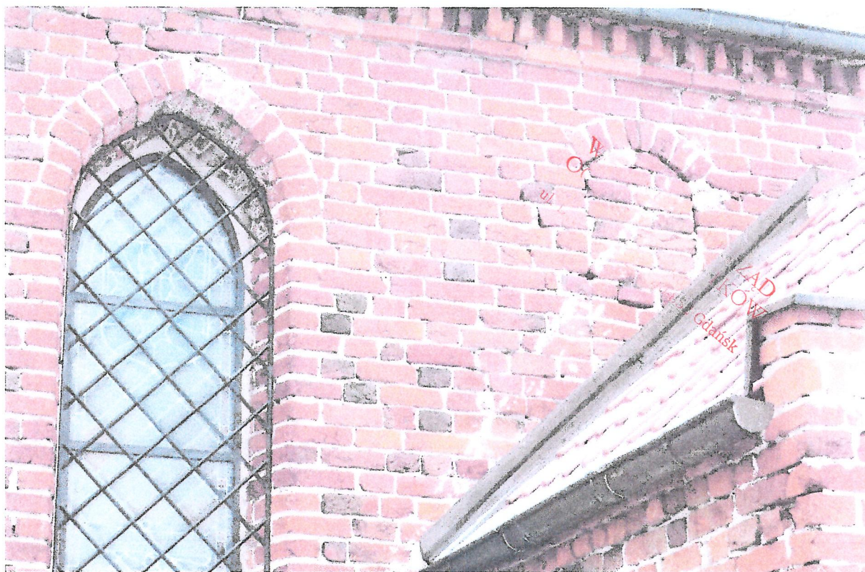
Fot.31 Fragment elewacji południowej z widocznym śladem po pierwotnym dachu kruchty.
