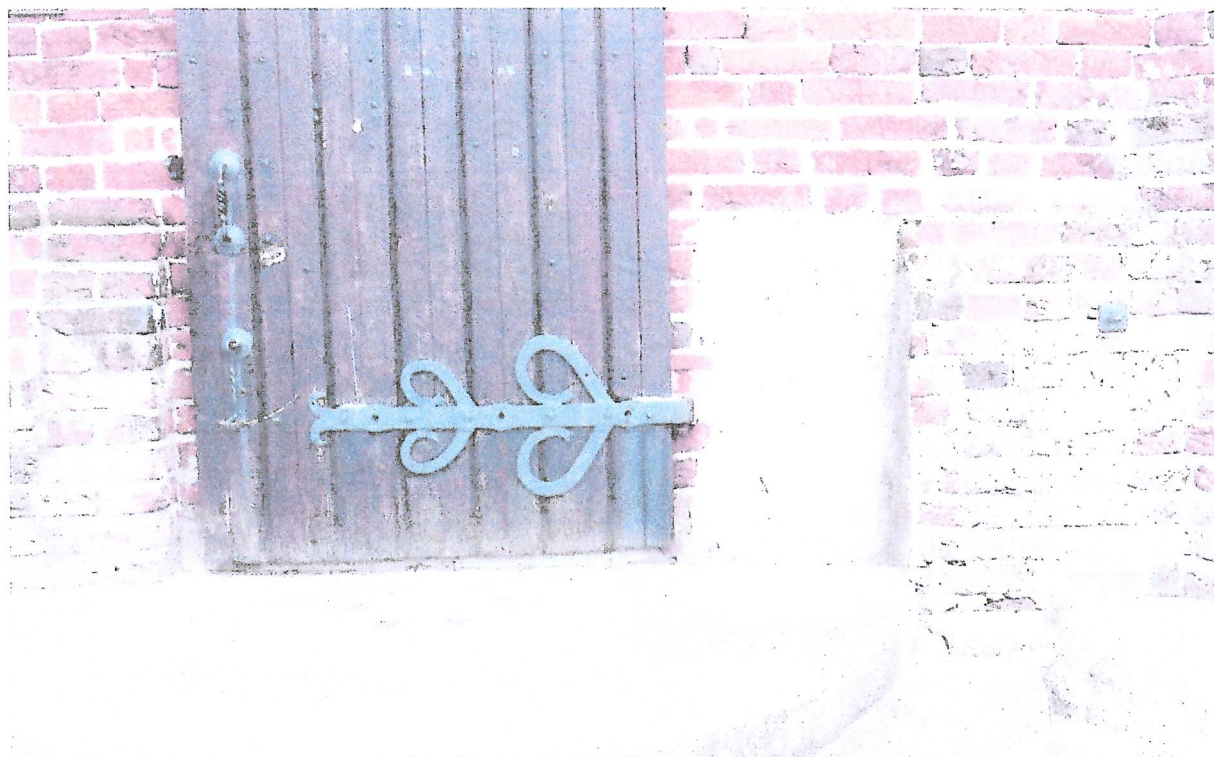
Fot.28 Wtórne spoinowanie oraz tynki przy głównym wejściu.
