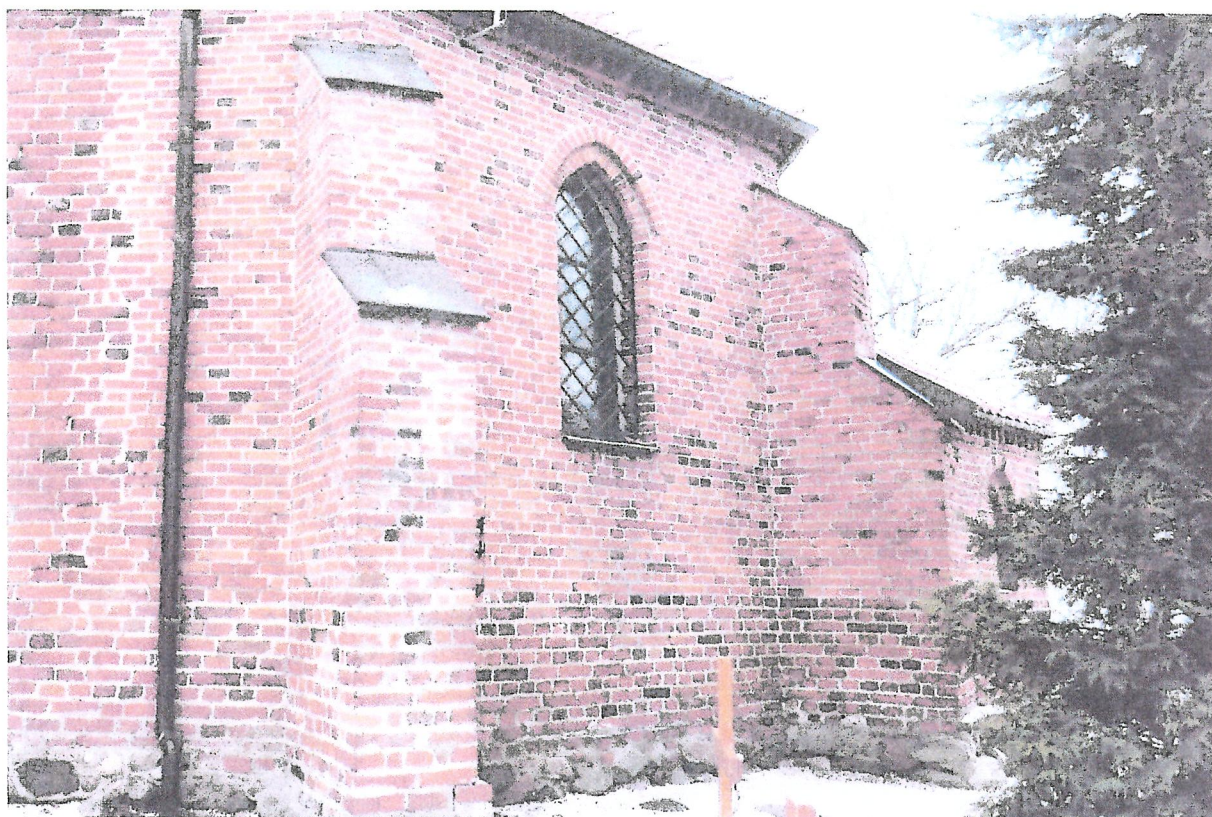
Fot.4 Południowo-wschodnia część prezbiterium. Widoczne łączenie z gotycką ścianą nawy.
