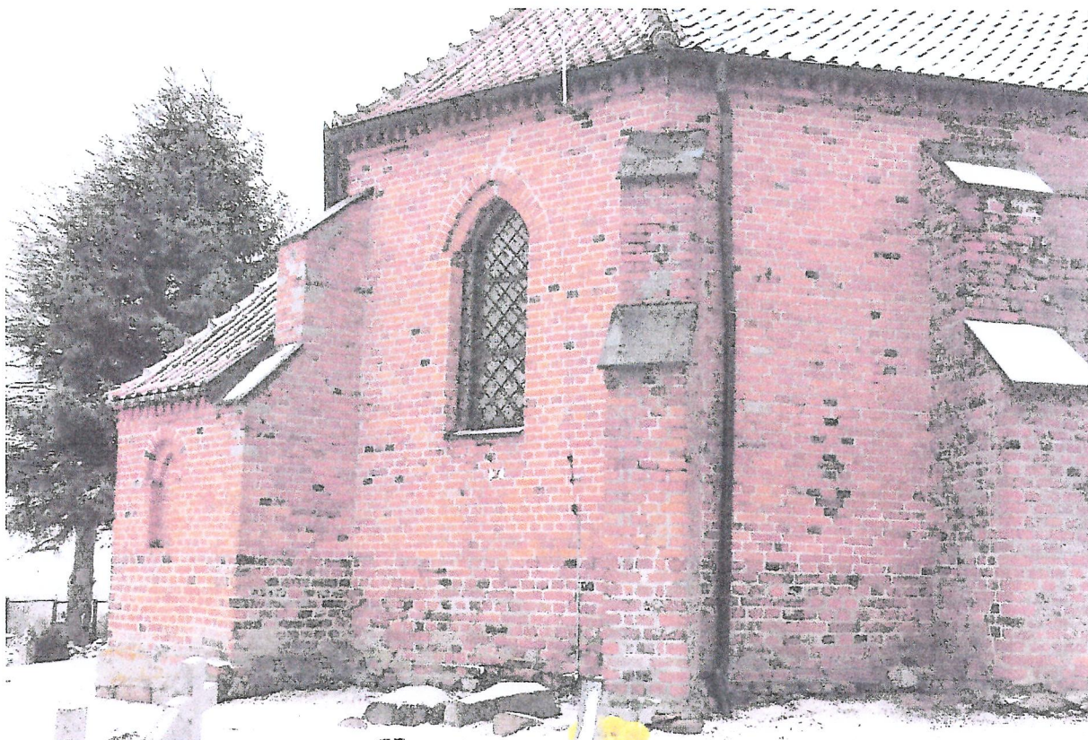
Fot.3 Północno-wschodnia część prezbiterium odbudowanego na przełomie XVIII/XIX w.
