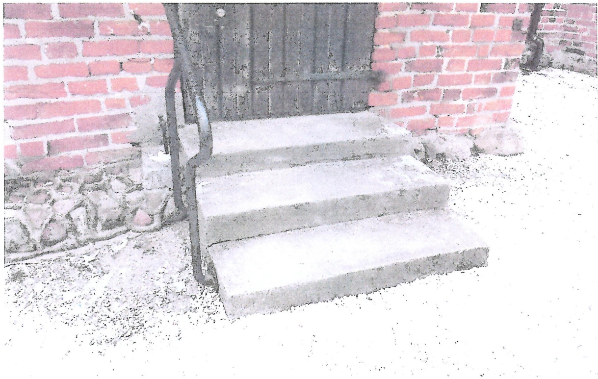
Fot.34 Wtórne, betonowe stopnie schodów kruchty południowej kościoła.
