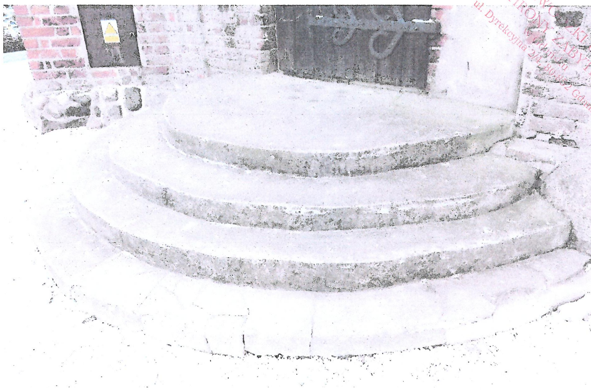
Fot.7 Betonowe schody głównego wejścia (od strony zachodniej).
