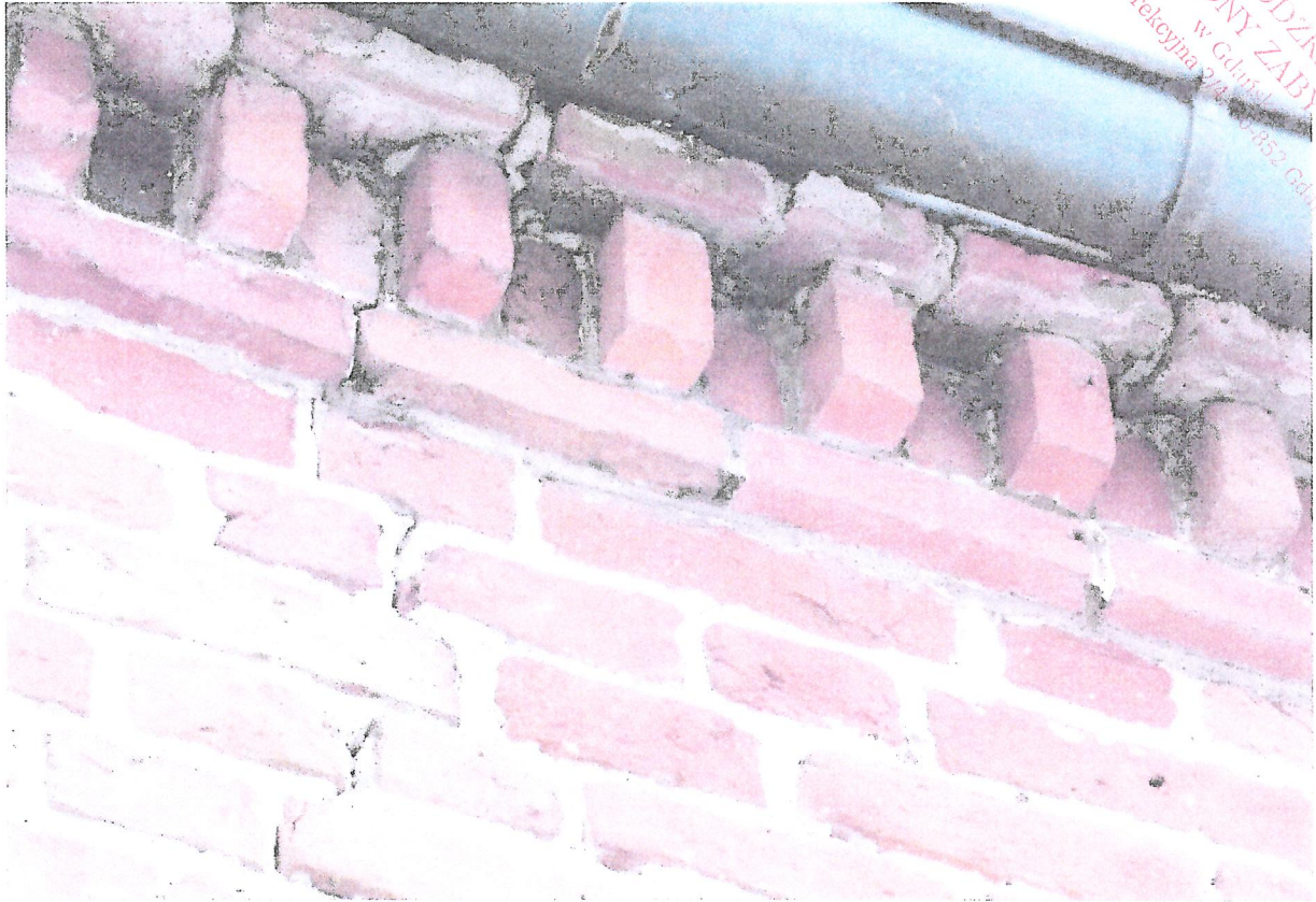
Fot.19 Dekoracyjny gzyms podokapowy wymurowany wtórnie z cegieł gotyckich.
