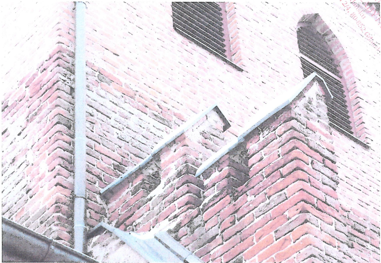
Fot. 23 Wtórne przemurowania sterczyn ze zwieńczenia ściany zachodniej.
